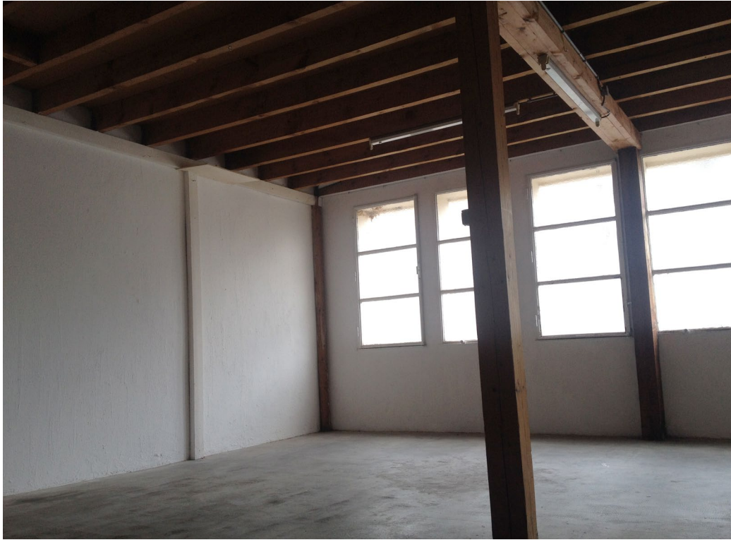
Vue de l'entrepôt - salle annexe
