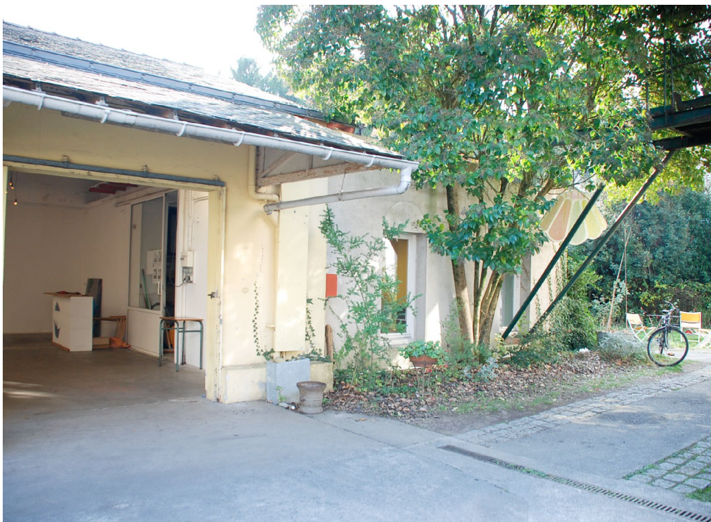
Vue de l'extérieur - entrée de l'entrepôt
