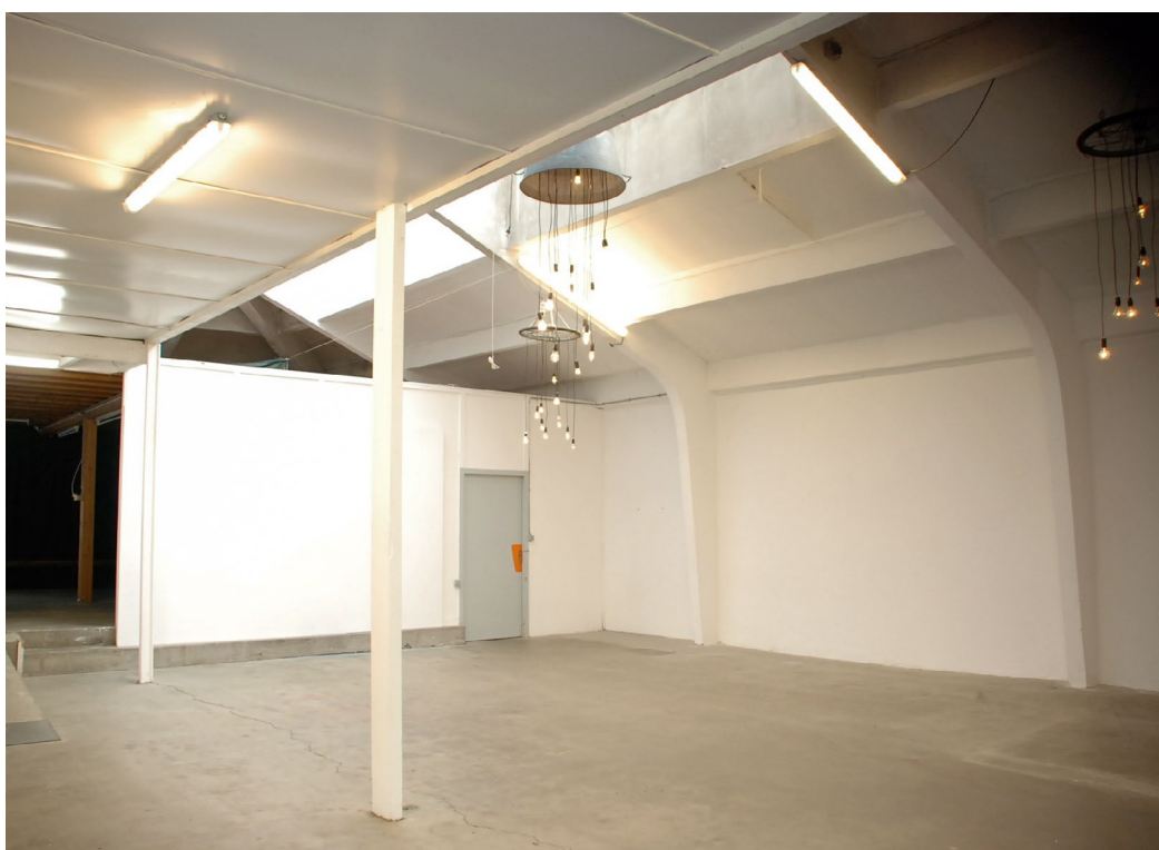
Vue de l'entrepôt - salle principale
